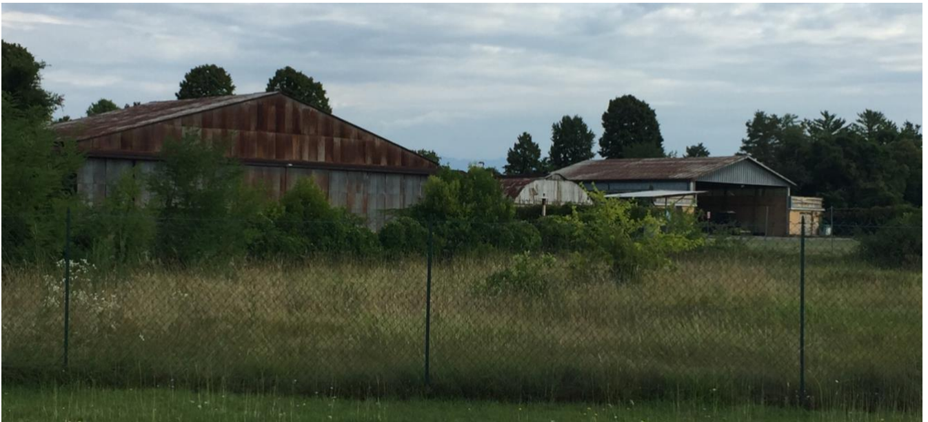
Die Hangars in Campofornido haben schon bessere Zeiten gesehen
